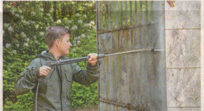
Mit einem Dampfstrahler befreit Diplom-Restauratorin Uta Dederichs das Portal von Bewuchs und Schmutz.
